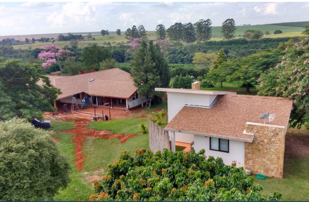
Obra Rural - Pratânia/SP
