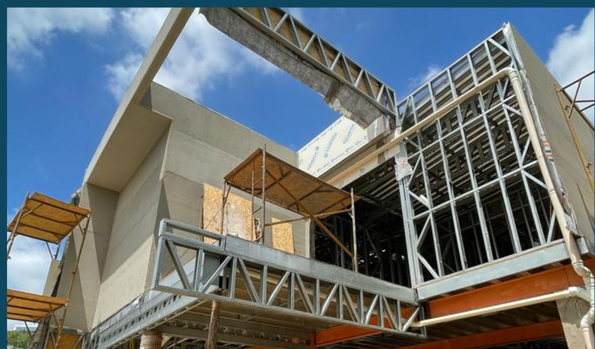
Obra Residencial- Belo Horizonte/MG
